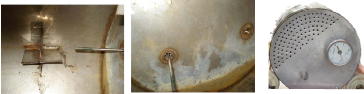
Imagen 2-10 Vista de baffle y sensor de temperatura
